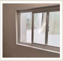
ENCUENTRO MARCO-VANO INSTALADO
