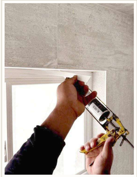
ETAPA 06 · SELLADO PERIMETRAL EN OBRA
